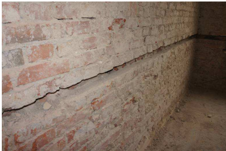
Fot. 19. Bruzda w ścianie konstrukcyjnej.
