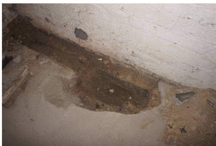
Fot. 21. Odkrywka fundamentów.
