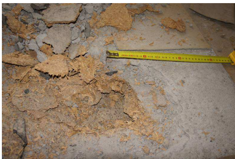
Fot. 14. Odkrywka posadzki na stropie nad piwnicą.
