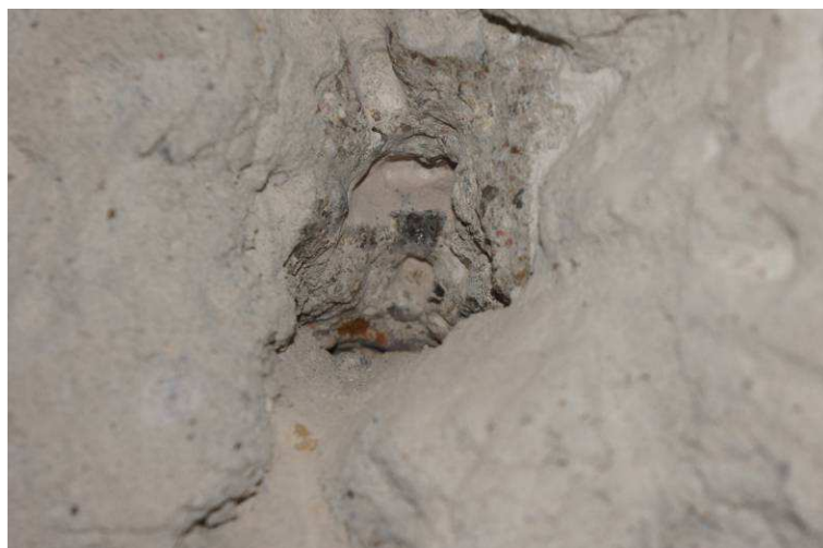
Fot. 8. Odkrywka (od strony płd.) podciągu nad ścianą piwnicy gr. 25cm.
