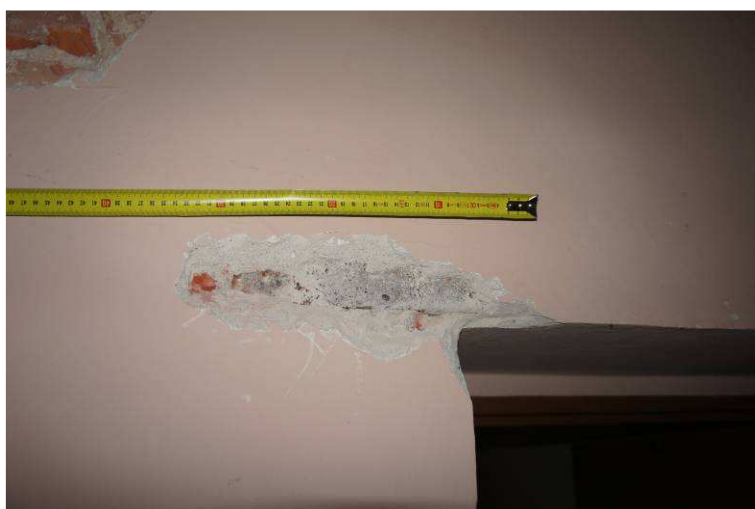
Fot. 18. Odkrywka nadproża nad drzwiami przy schodach na I piętrze.
