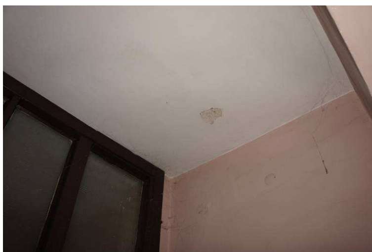
Fot. 17. Odkrywka w stropie na szerokości klatki schodowej nad parterem.
