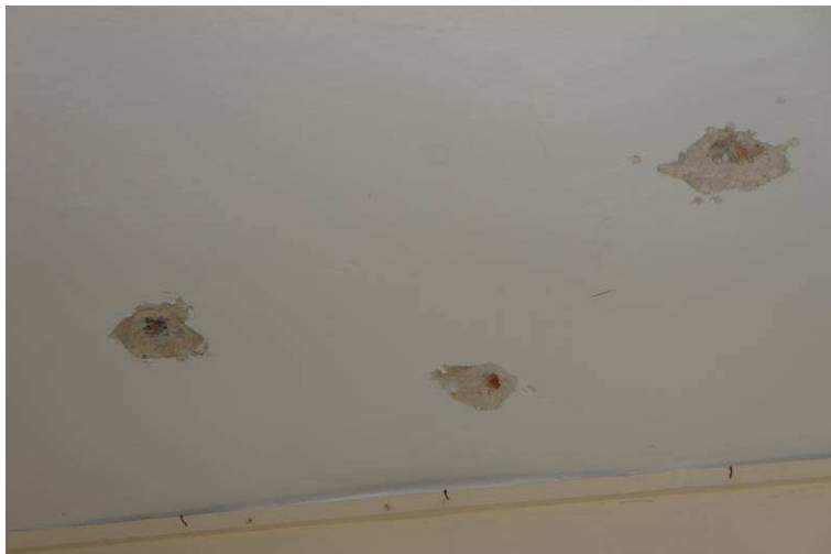
Fot. 16. Odkrywka w stropie na szerokości klatki schodowej nad I piętrem.
