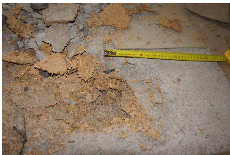
Fot. 14. Odkrywka posadzki na stropie nad piwnicą.
