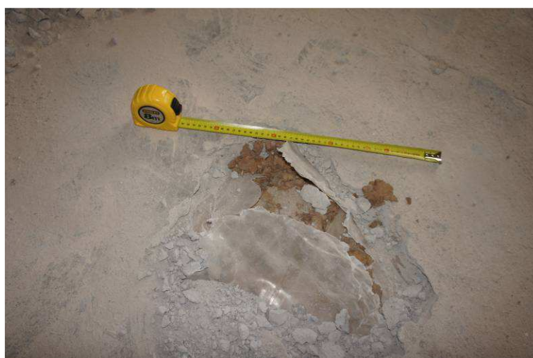
Fot. 12. Odkrywka posadzki na stropie nad I piętrem.
