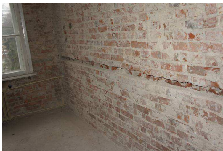
Fot. 20. Bruzda w ścianie konstrukcyjnej.
