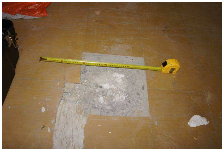
Fot. 13. Odkrywka posadzki na stropie nad parterem.
