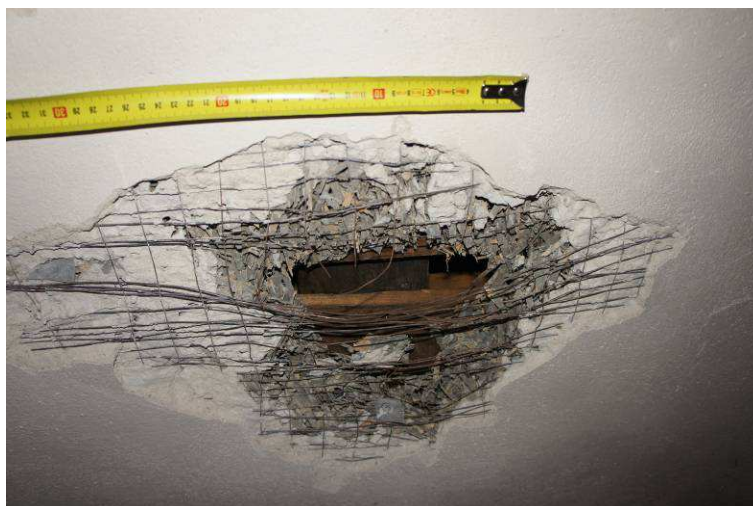
Fot. 10. Odkrywka warstw wykończeniowych połaci dachu w poziomie poddasza.
