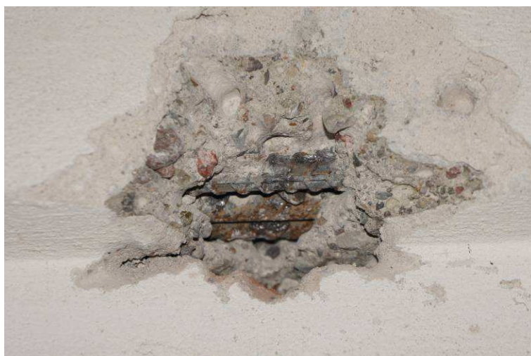
Fot. 8. Odkrywka (od strony płd.) podciągu nad ścianą piwnicy gr. 25cm.
