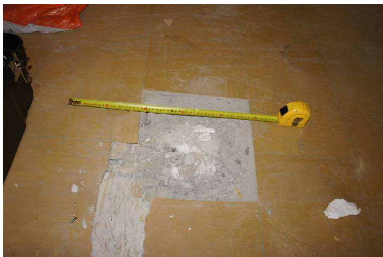
Fot. 13. Odkrywka posadzki na stropie nad parterem.
